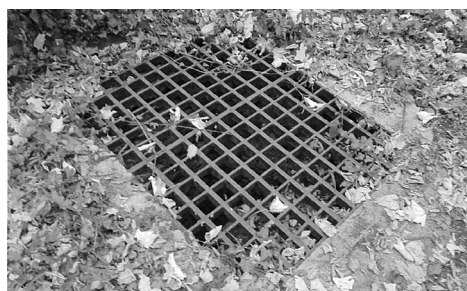
Fig. 2. Pozzo profondo 8 metri.
